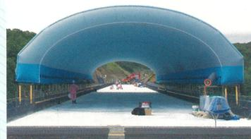
常磐自動車道の橋梁工事では雨天時にもコンクリート打設作業ができるように4つが連なるように使用。打設に沿って移動しながら全天候型の現場を実現。工事終了後は、イベントや災害対策用として使用予定。
